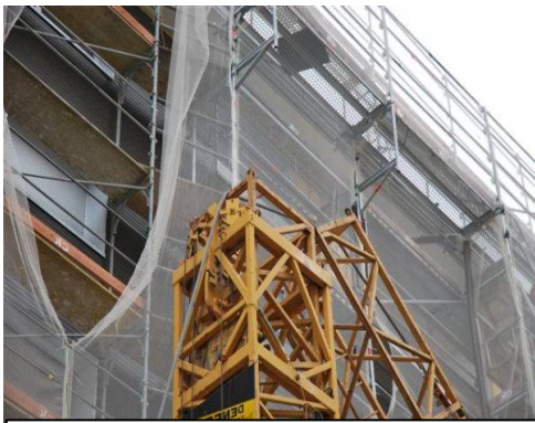
หอคอยถล่มแบบพับโค่น
